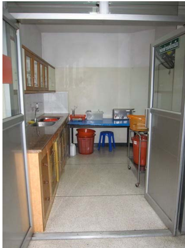
สภาพการใช้พื้นที่ภายในห้องล้างเครื่องมือ
