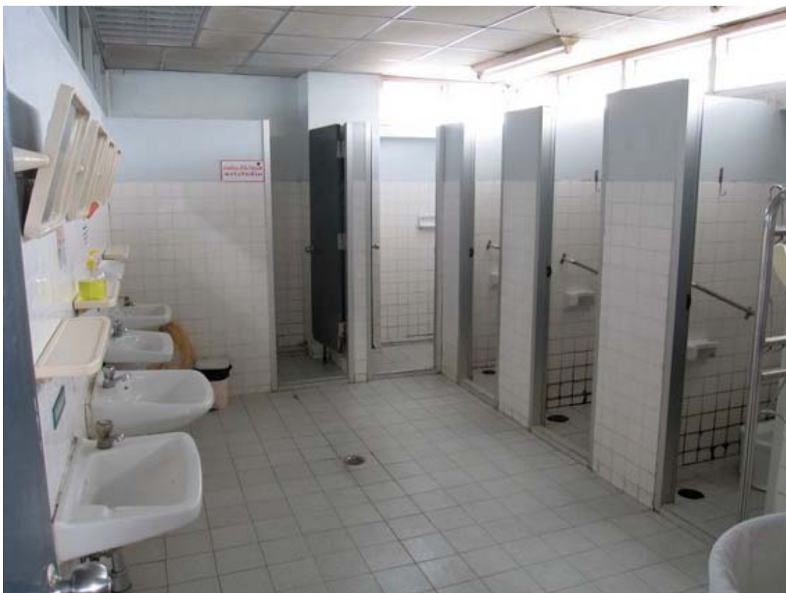
สภาพการใช้พื้นที่ภายในห้องอาบน้ำ-ส้วมสำหรับผู้ป่วย
