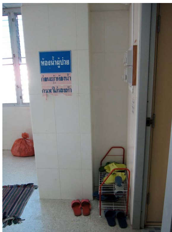
สภาพการใช้พื้นที่ภายในห้องอาบน้ำ-ส้วมสำหรับผู้ป่วย
