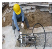
7. อัดแรงคอนกรีต
