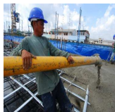
6. เทคอนกรีต
