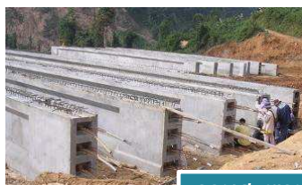
คานสะพาน
