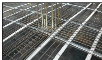
เหล็กเสริมรับแรงเฉือน
