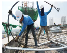
3. สอดลวดอัดแรงเข้าในท่อซีพ
