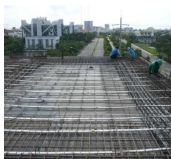
5. วางเหล็กเสริมบน
