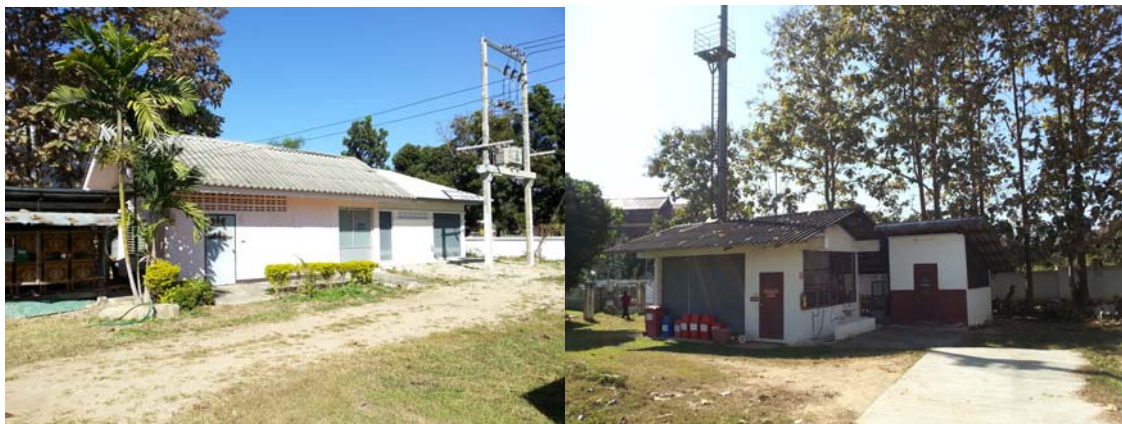
รูปภาพแสดง อาคารโรงไฟฟ้าสำรอง และอาคารพักขยะ
